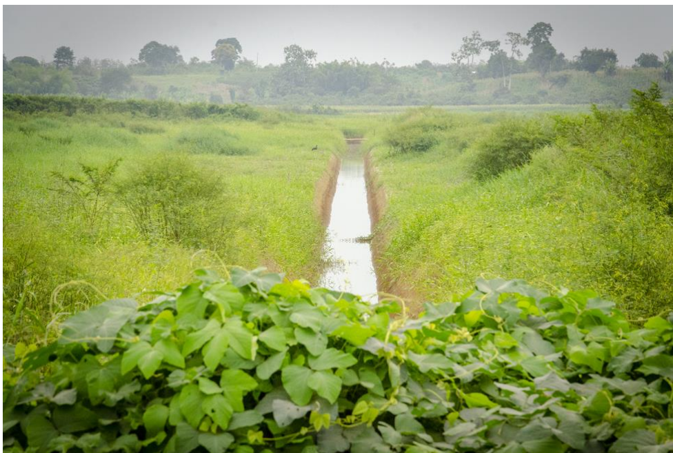
Foto 6: (Zona 2) Canal construido para el drenado del humedal (15-07-2022)
