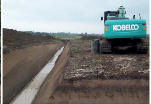
**Foto 22** :Ampliación del canal natural de drenaje del humedal. **Foto 23**: Maquinaria construyendo el canal de drenado artificial con dirección al río Quevedo.
